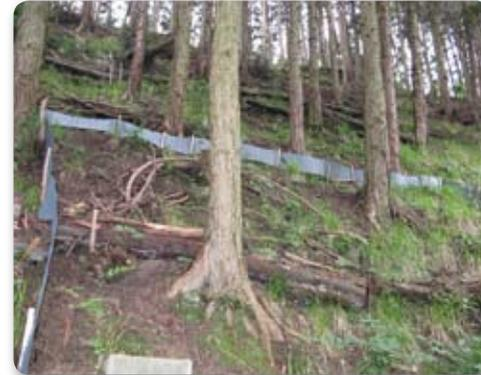
土砂受け箱を用いた丸太筋工法の効果検証
